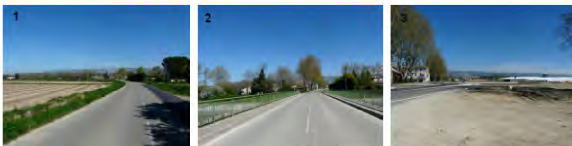
Point d'accroche avec le village – Zone à enjeux
