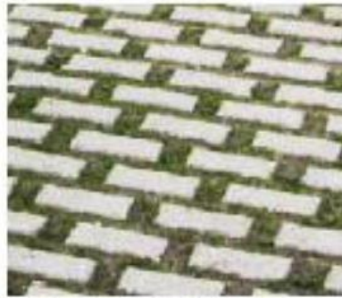
Pavage en béton avec ouvertures de drainage
