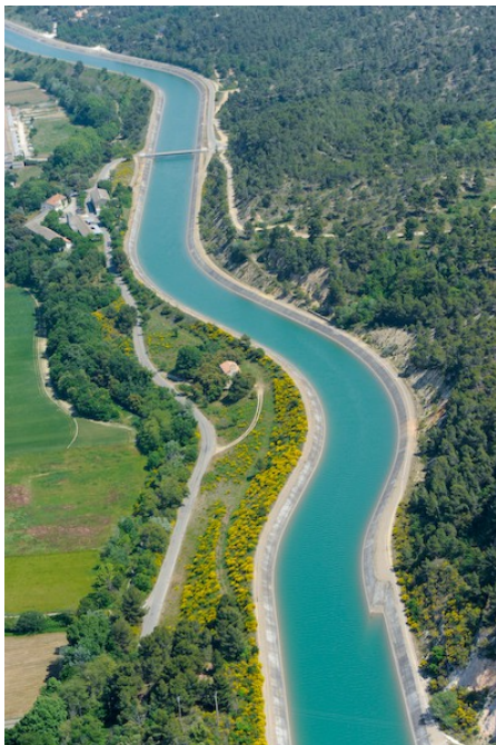
Photos du canal EDF
